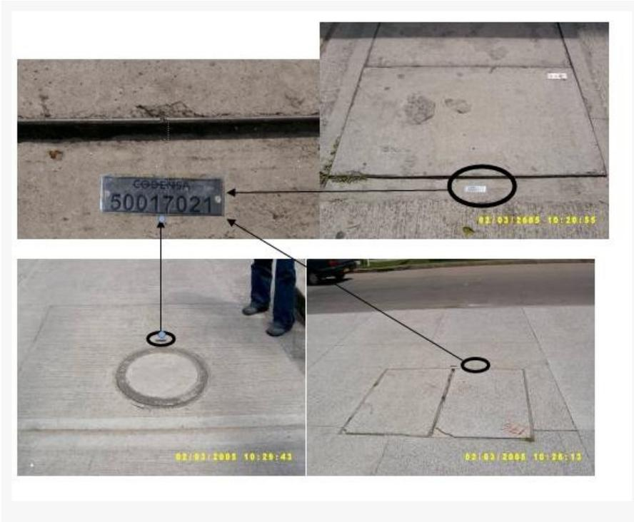
Adicionalmente a la **instalación** de la placa, se debe hacer la marcación del mismo código de la placa metálica en el interior de cada cámara subterránea, el tamaño de los números debe ser: largo 5 cm, ancho 3.0 cm y una separación de 1.5 cm, la pintura usada para la marcación debe cumplir con la **especificación técnica ET952**.
